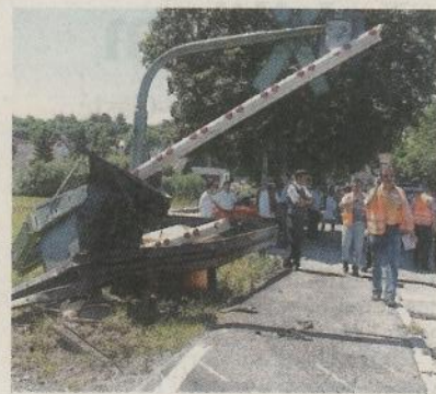
Auch die Schrankenanlage wurde bei dem Aufprall des Pkw zerstört.
